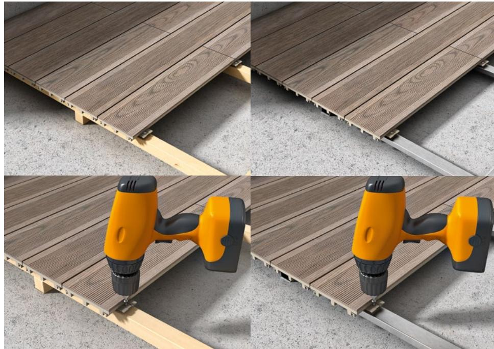
**Partindo da primeira fiada, aplicar o DEX de forma contínua através dos clips devidamente aparafusados**
